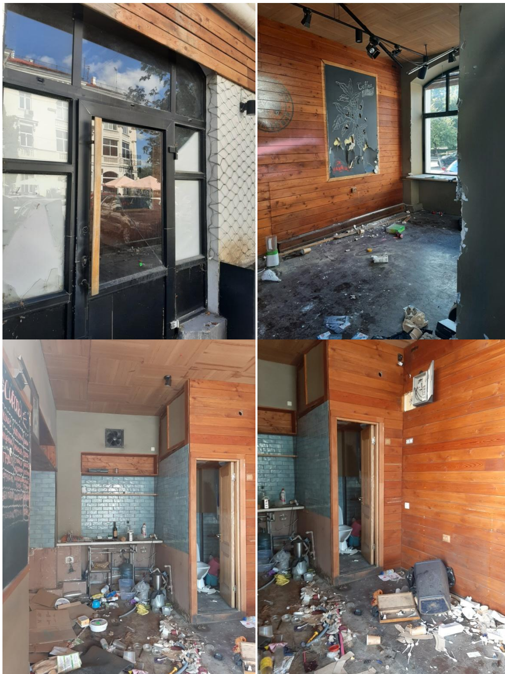
Общий вид помещения
